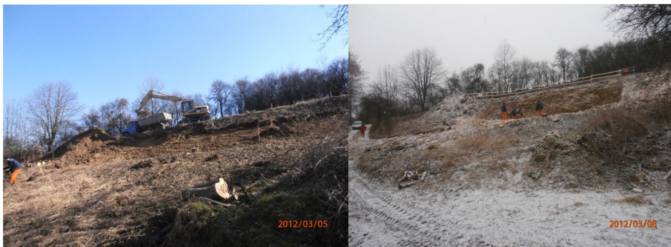
Počátek bagrování svahu a první práce pod Březinkou pro základy stávající budovy ČOV
